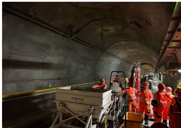
En haut : pose de nouvelles voies. En bas : bétonnage de la voie.
