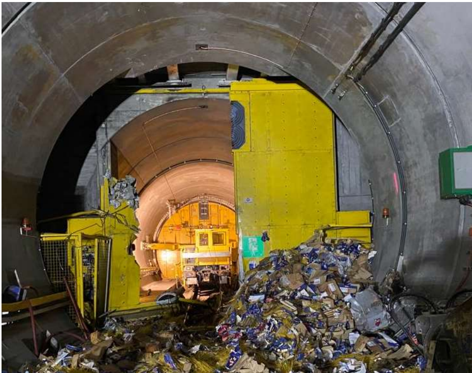
Porte de la diagonale d'échange défoncée
