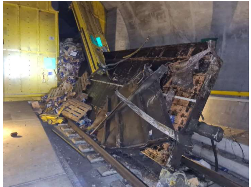
Vue arrière de la porte de la diagonale d'échange défoncée
