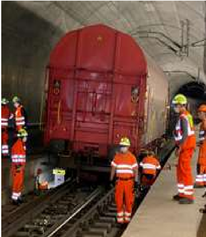
Déblaiement du tunnel (wagons déraillés et leur chargement)
